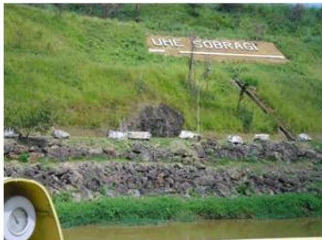
Enrocamento próximo a Casa de Força e na margem direita do Reservatório
