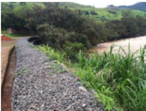
Enrocamento próximo a Casa de Força e na margem direita do Reservatório
