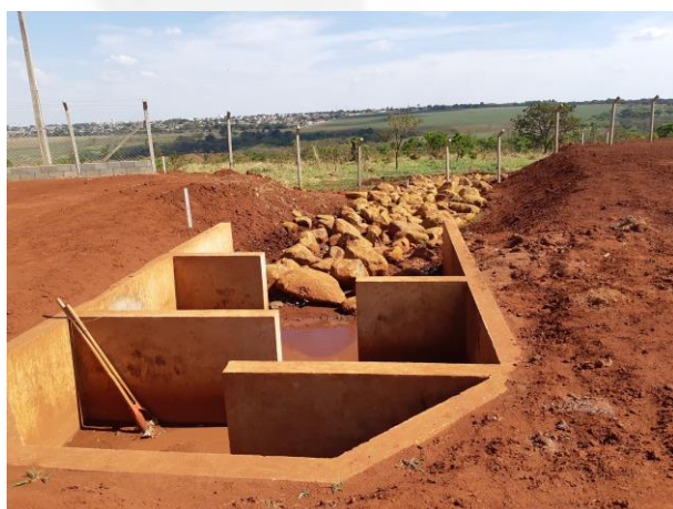
Foto 03. Dissipador de energia seguido por enrocamento
