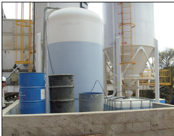
Foto 05. Depósito de Aditivos, área com bacia de contenção.
