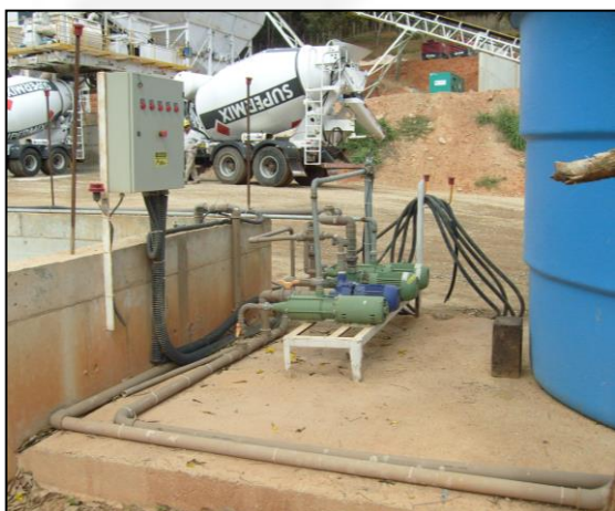
Foto 06. Sistema de Recirculação da água tratada pelo sistema Bate-lastro.
