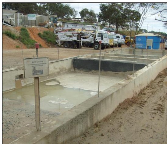
Foto 03. Sistema de sedimentação dos resíduos sólidos (Bate-lastro) do efluente de lavagem dos caminhões betoneiras.
