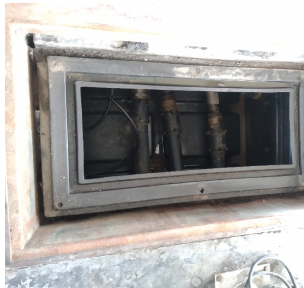
Figura 6: Sump (reservatório de contenção) do filtro de diesel.
