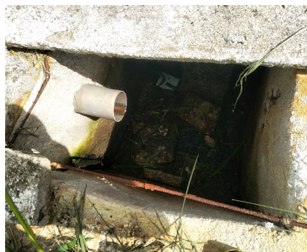
Figura 8: Caixa separadora de água e óleo, compartimento final.
