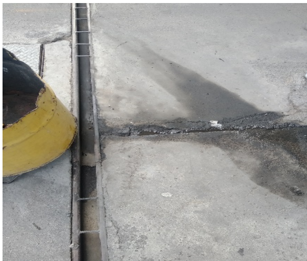
Figura 5: Trincas aparentes na pista de abastecimento.
