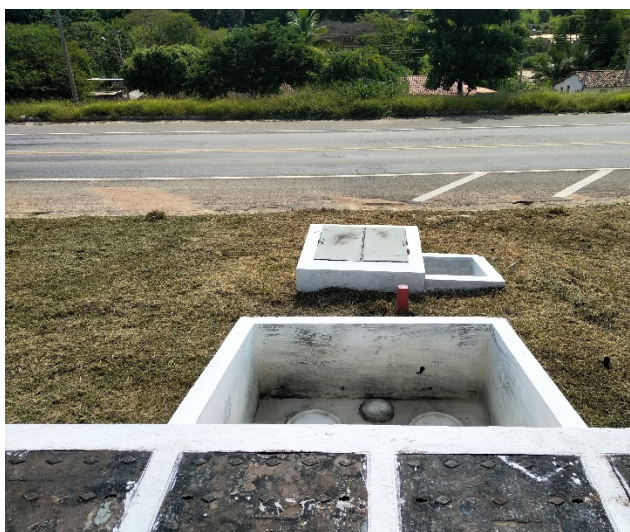
Figura 7: Caixa separadora de água e óleo.
