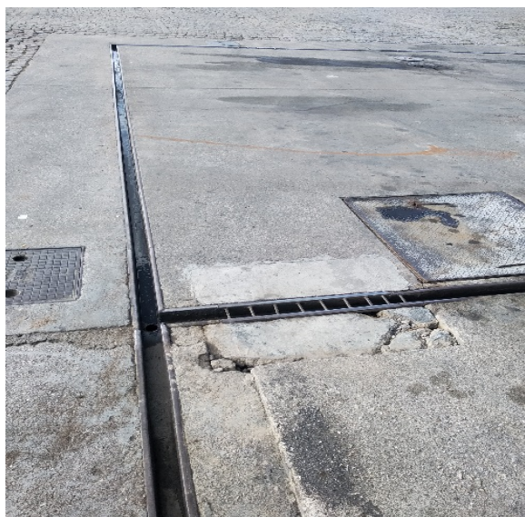
Figura 3: Trincas aparentes na pista de abastecimento.
