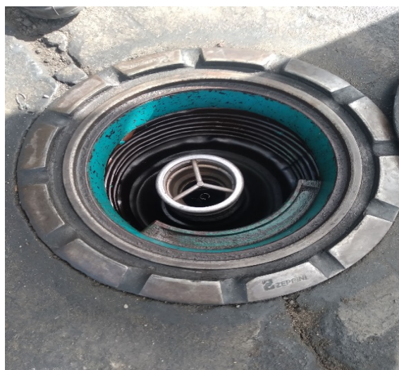
Figura 2: Bocal (anel) de vedação para descarga selada .
