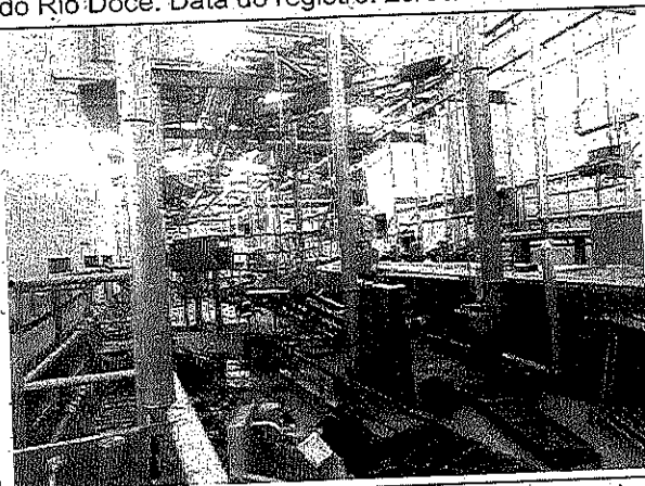
Foto 05. Empreendimento em instalação. Data do registro: 08/12/2017.
