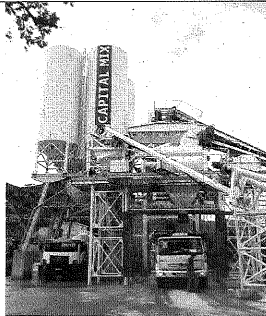
Foto 04. Central misturadora e central dosadora
