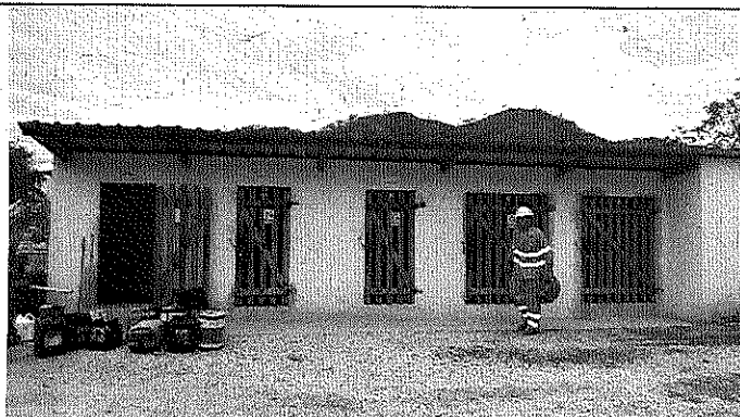
Foto 06. Depósito de Resíduos Classe 1.
