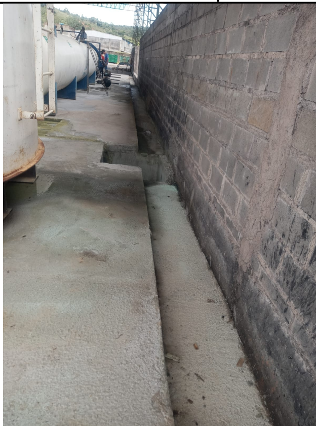
Foto 10: Sistema de drenagem da área de contenção.
