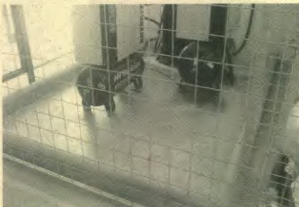
Foto 03 – Compressorés com bacia de contenção
