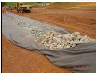
Implantação do sistema de drenagem de líquidos percolados (retirado de PARECER ÚNICO Nº 260282/2010 SUPRAM-ZM)
