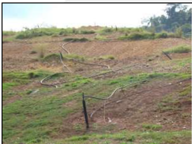
Sistema de drenagem de gases – Fase 1
