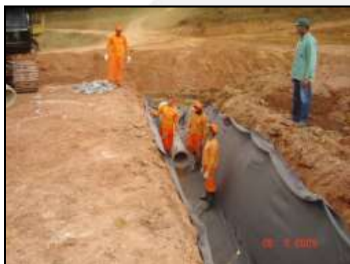
Sistema de drenagem de base (envelopamento da nascente localizada na área de implantação do maciço de resíduos) – imagem retirada do PU Nº 260282/2010.
