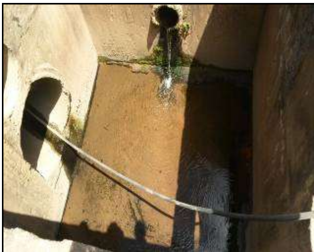
Saída dos drenos a jusante do aterro de inertes – caixa de retenção de sólidos (retirada em 01/11/2016 durante a vistoria).
