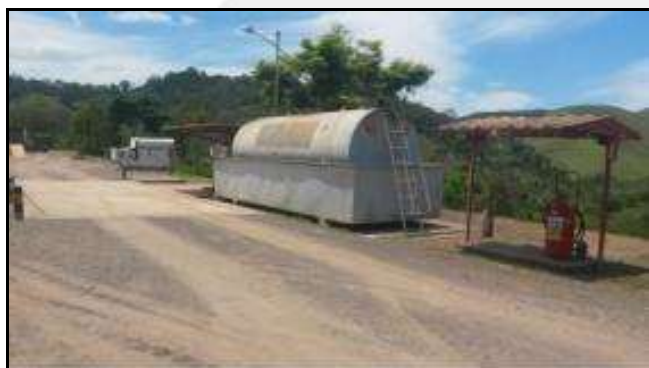
Tanque aéreo, 15m 3 , diesel, instalado sobre bacia de contenção de vazamentos, interligada à caixa SAO.
