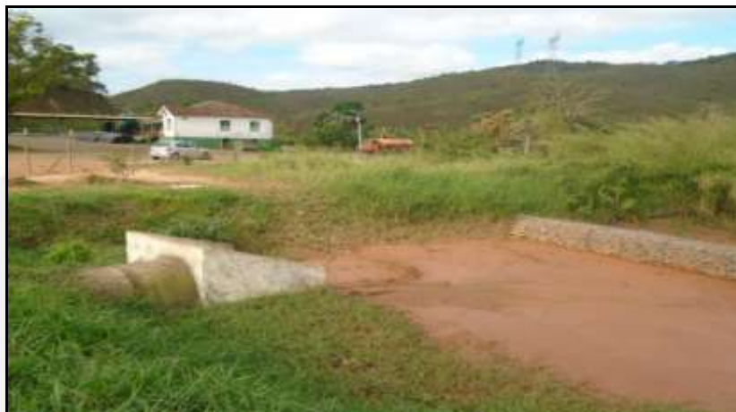
Caixa seca, protegida por estrutura de gabião, construída no final do sistema de drenagem pluvial, com a finalidade de reter os sólidos, impedindo o seu arraste para o interior da drenagem.
