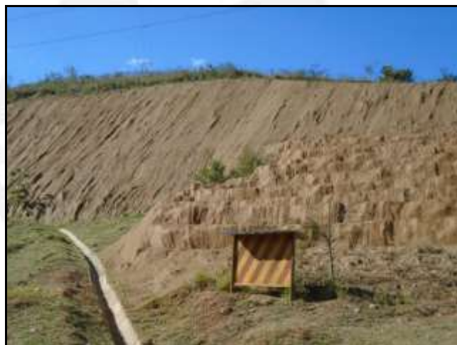
Área PE-09 após a execução do PRAD – construção canaletas de drenagem e revegetação dos taludes.
