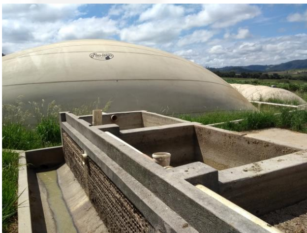
Foto 03. Caixas de decantação e biodigestores---
