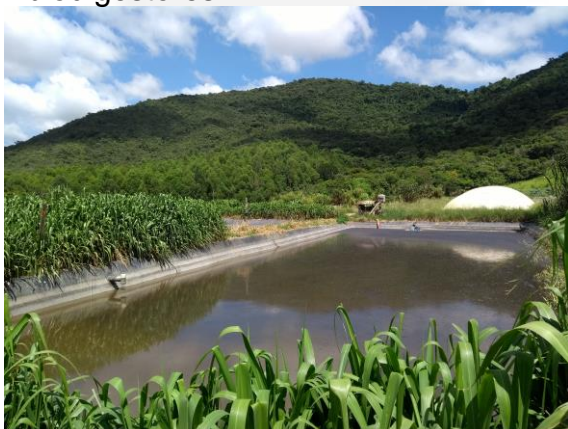
Foto 03. Lagoa de estabilização de efluente após passar pelo biodigestor---
