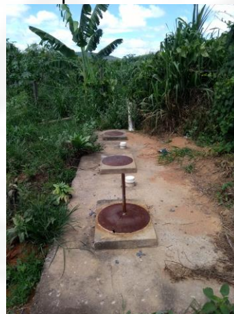
Foto 02. Caixa de passagem do efluente das baias para a caixa de decantação
