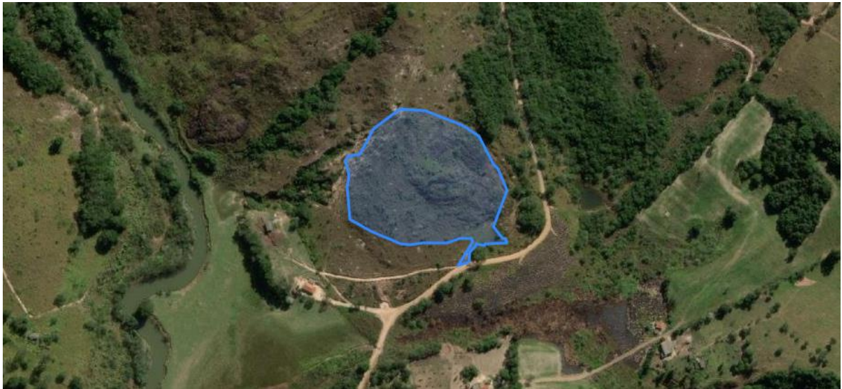
Figura 1 - Visão geral da área do empreendimento
