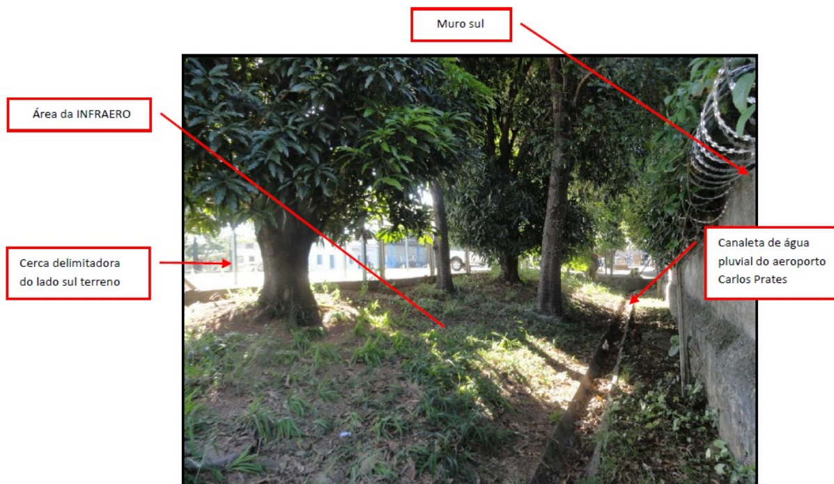
Foto 03 – Canaleta de água pluvial do Aeroporto Carlos Prates.
