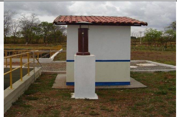
Figura 3: Queimador de Gases
