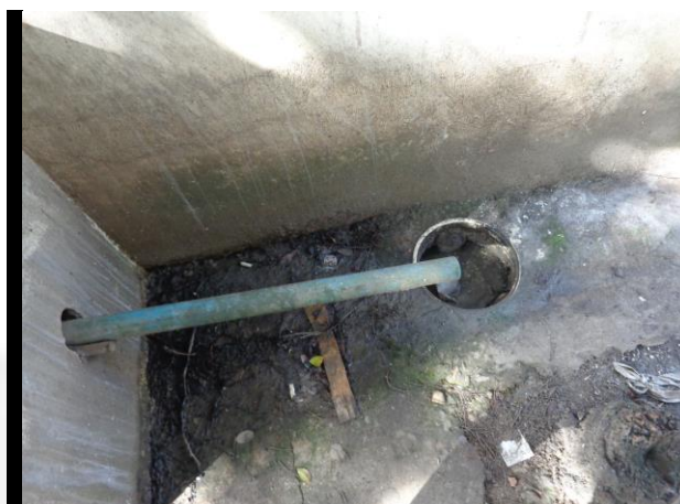
Foto 06. Caixa de gordura do refeitório, destampada e com sinas de derramamento.
