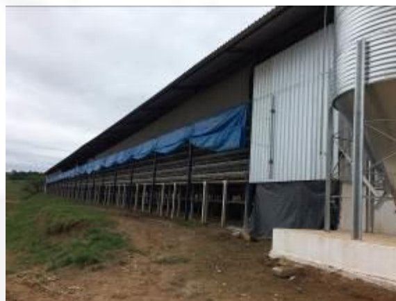
Foto 04 - Galpão em operação.
