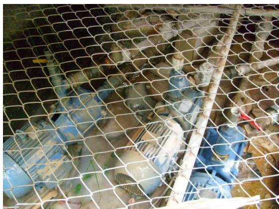
Foto 05 – sistema de bombeamento de água reutilizada
