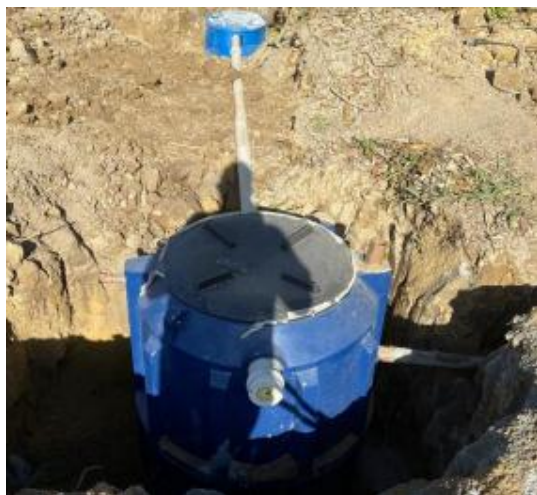
Imagem 09 e 10: Instalação de sistema de tratamento
