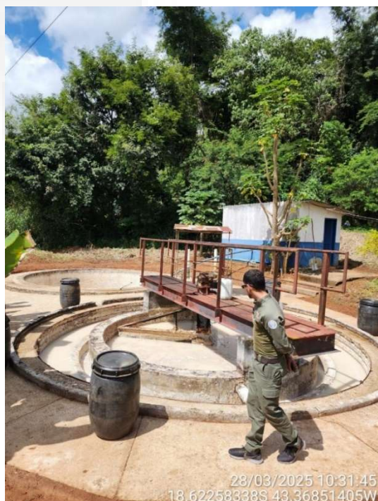
Foto 7: Estrutura integrante do sistema de tratamento de efluentes (caixa de gordura e tanque equalizador)
