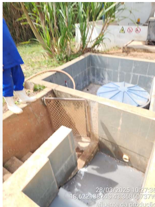
Foto 6: Estrutura integrante do sistema de tratamento de efluentes (peneira estática)
