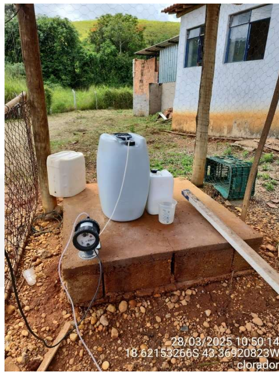
Foto 16: Clorador da água do poço
