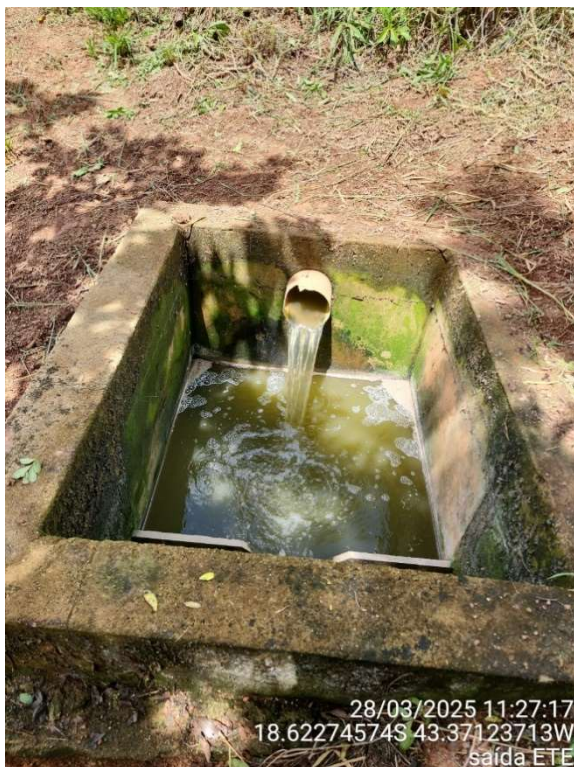
Foto 13: Vertedouro da saída da ETE
