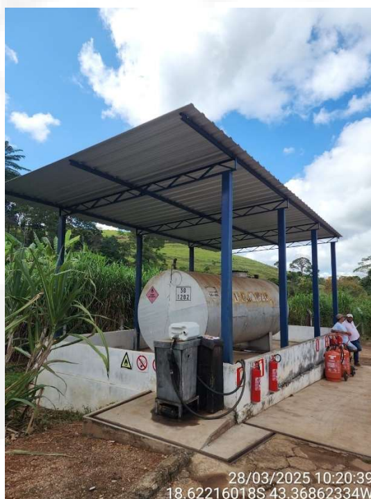
Foto 4: Tanque aéreo de combustível com ponto de abastecimento
