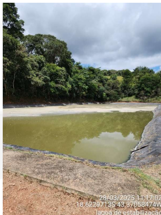
Foto 8: Estrutura integrante do sistema de tratamento de efluentes (Lagoa anaeróbia)
