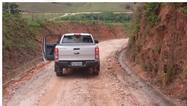
Figura 2 – Canaletas para água pluvial em estrada vicinal ao lado de sinalizadores do gasoduto
