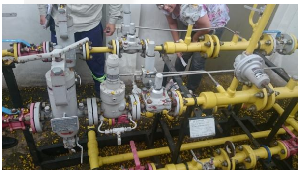
Figura 8 - Conjunto de Medição e Regulagem de Pressão - CMRP no ponto de recebimento do gás por um cliente da Gasmig
