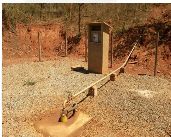
Foto 13: Captação em poço tubular.
