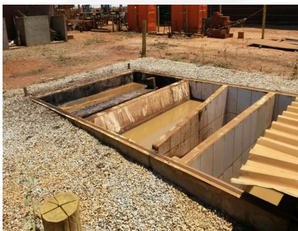
Foto 19: Caixa separadora de água e óleo.
