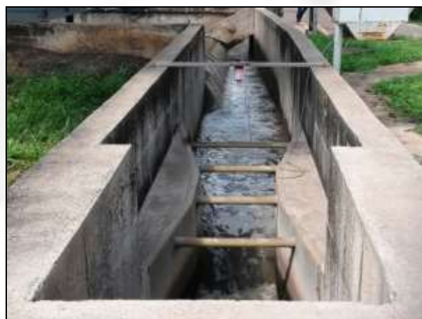
Foto 04. Calha Parshall e medidor ultrassônico
