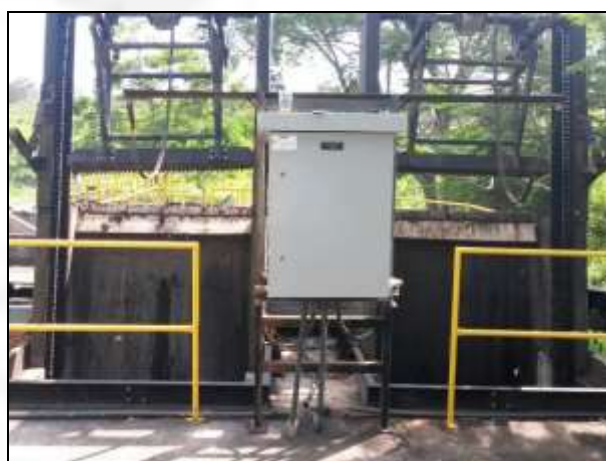
Foto 02. Gradeamento mecanizado
