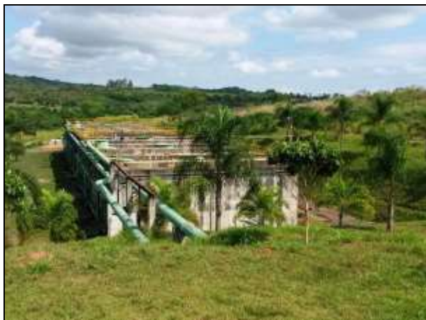
Foto 05. Reatores anaeróbios (RAFAs)
