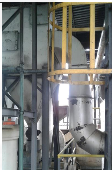
Foto 02. Ciclone acoplado na caldeira.
