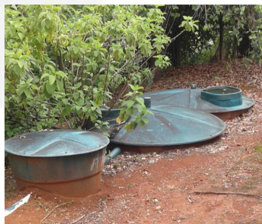
Foto 04. Sistema de tratamento de efluentes sanitários.
