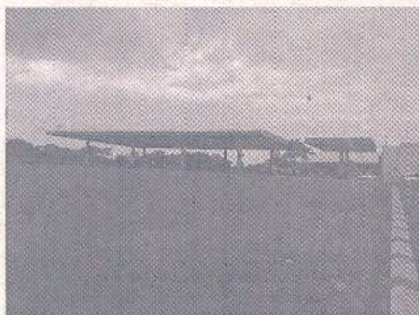
Foto 01. Visão geral do posto
