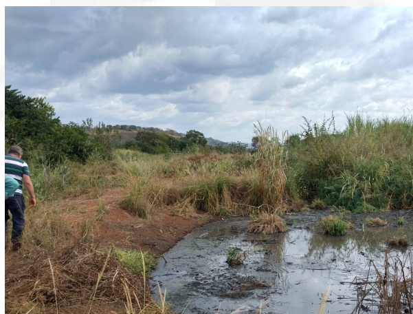
Figura 4. Bolsão não impermeabilizado de armazenamento de efluente da suinocultura
