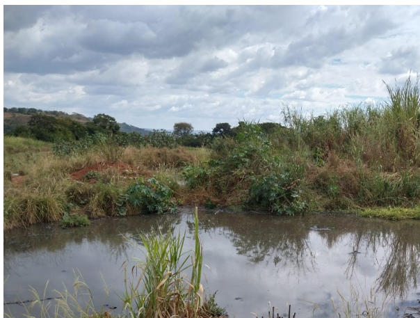
Figura 1. Bolsão não impermeabilizado de armazenamento de efluente da suinocultura
