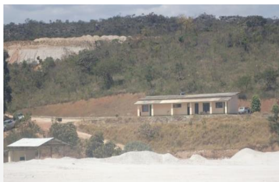
Figura 2. Estruturas do empreendimento, ao fundo galpão de apoio, a frente galpão de manutenção máquinas e equipamentos.
