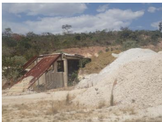
Figura 3. Estrutura para beneficiamento
