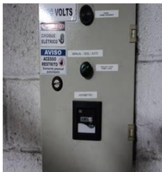
FOTO 4 – Horímetro do poço
