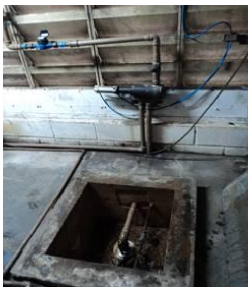
FOTO 3 – Poço (hidrômetro acima)
