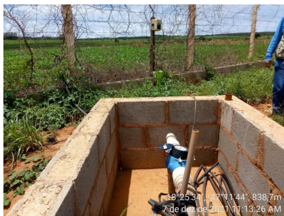
FOTO 06. Poço tubular
