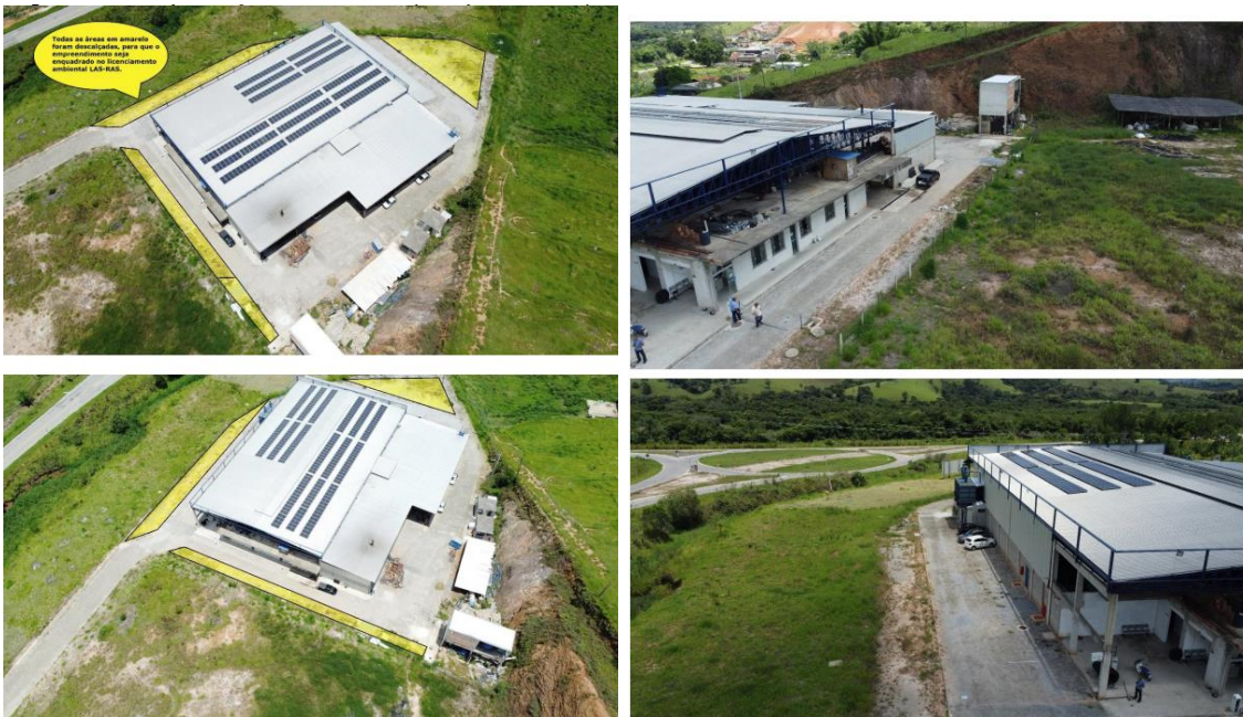
Figura 2: Áreas em que o calçamento removido. Fonte: SLA.
