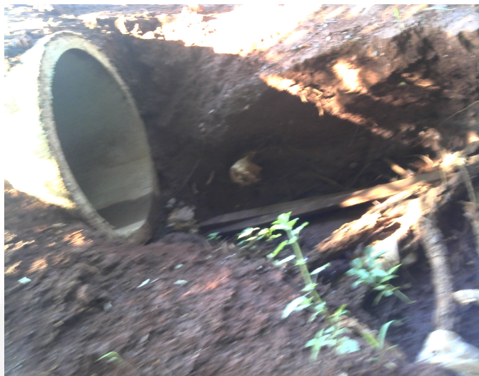
Figura 04 – Manilha desaguando no terreno da BT Construções
