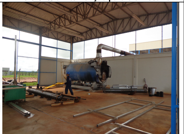
Figura 11- Montagem da Caldeira
