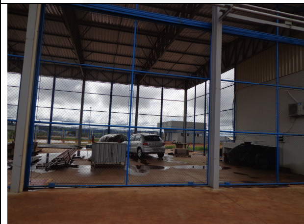
Figura 10- Oficina de reparos
