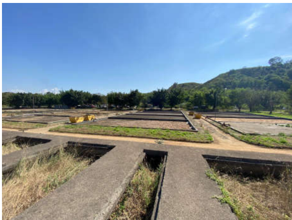
Foto 07: Leito de secagem de lodo.
