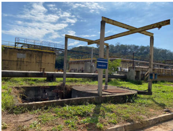
Foto 08: Sistema de drenagem pluvial – Elevatória.
