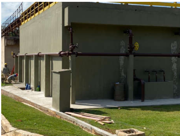
Foto 01: Reator UASB.
