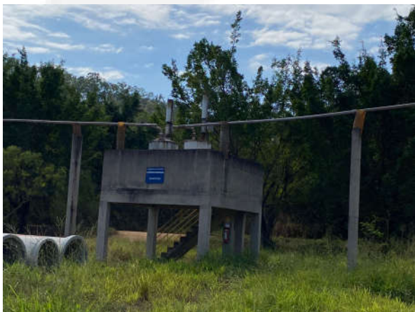
Foto 09: Queimador de gases.
