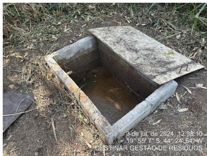
Foto 32: Saída da CSAO, com excesso de borra acumulada
