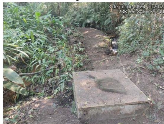
Figura 21. Estrutura de captação e distribuição hídrica do recurso hídrico existente, identificado dentro da Reserva Legal
