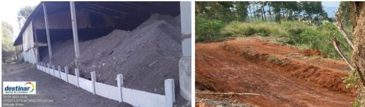
Figura 5. Sistema de contenção no entorno dos galpões e canaletas escavadas em solo
