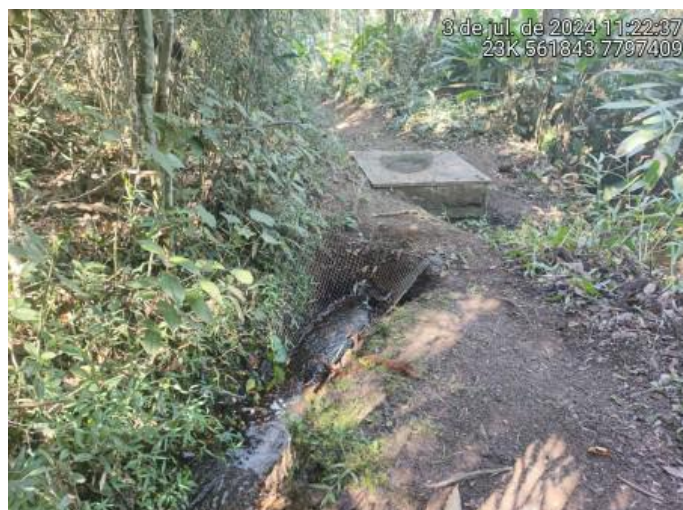
Foto 55: Curso d'água sendo direcionado para caixa de distribuição hídrica dentro da Reserva Legal.
