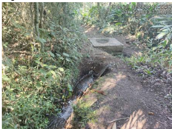
Figura 20. Curso d'água sendo direcionado para caixa de distribuição hídrica dentro da Reserva Legal
