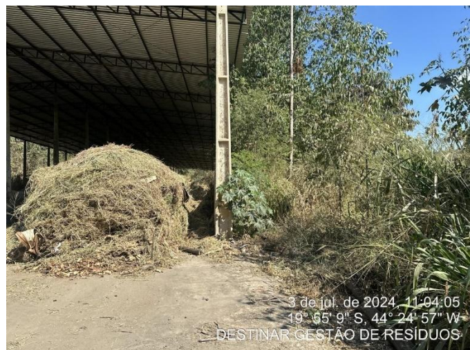
Foto 4: Galpão de recebimento, sem canaletas ao entorno
