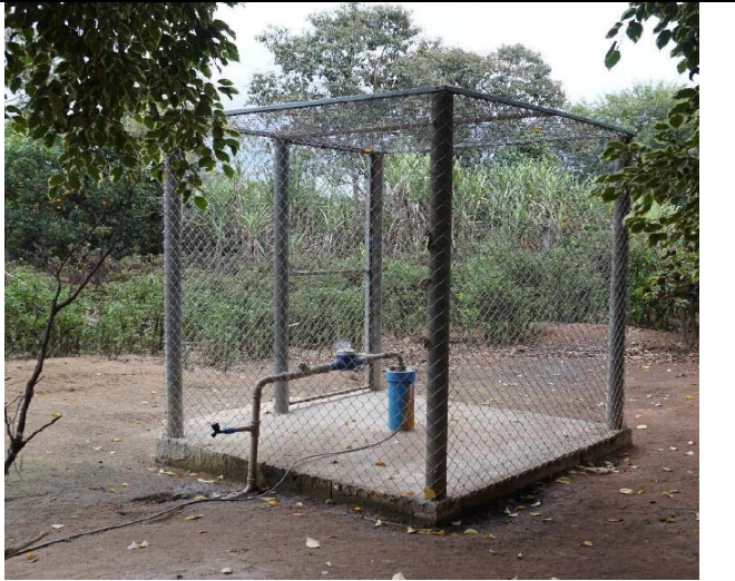
Figura 6. Poço tubular
