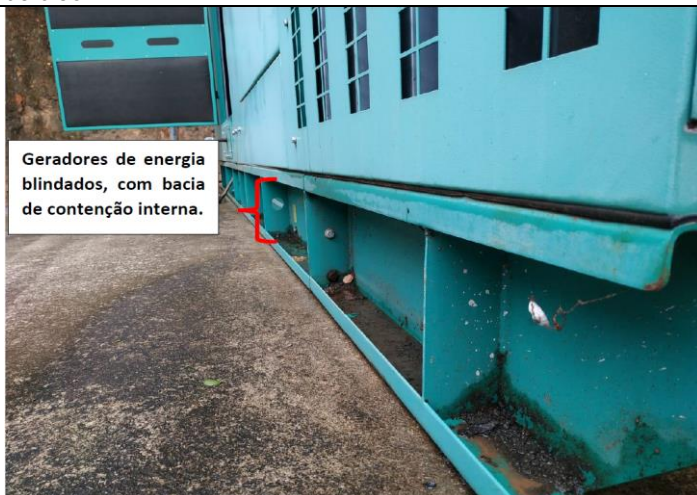
Figura 3. Bacia de contenção interna dos geradores
