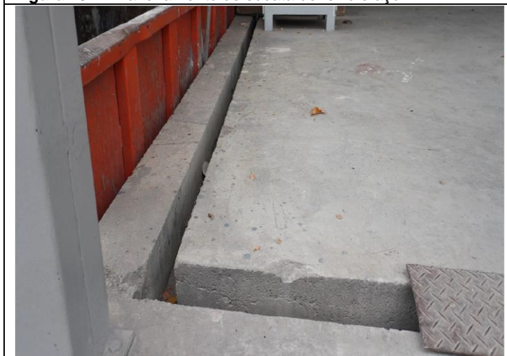
Figura 21. Caneleta do depósito classe I
