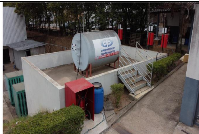
Figura 2. Tanque de armazenamento de óleo (geradores)
