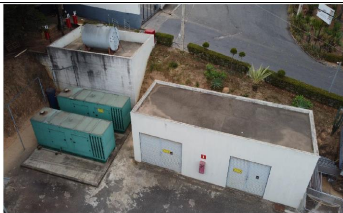
Figura 1. Geradores de Energia com tanque de armazenamento de óleo
