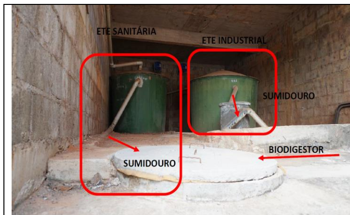
Figura 7. ETE Sanitária Unilider e ETE Industrial
