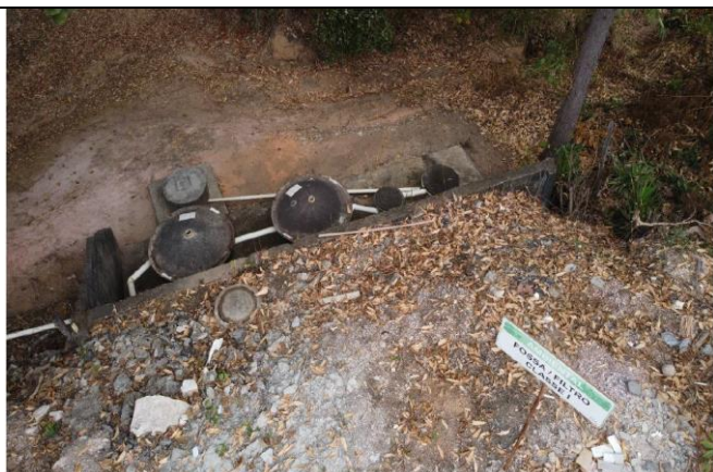
Figura 14. Sistema de tratamento lavagem de veículos (caixa SAO + fossa/filtro/sumidouro)
