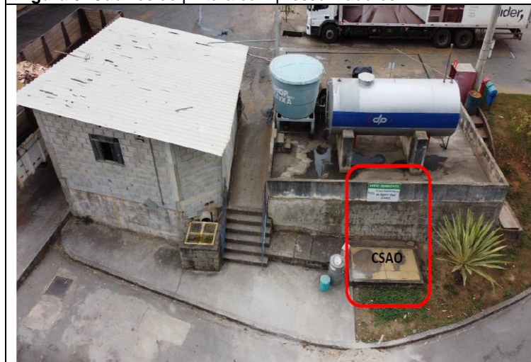
Figura 11. Ponto de Abastecimento com caixa SAO
