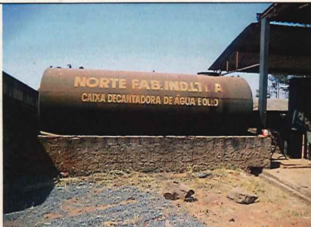
Foto 05: Sistema separador de água e óleo; 01/09/2017.
