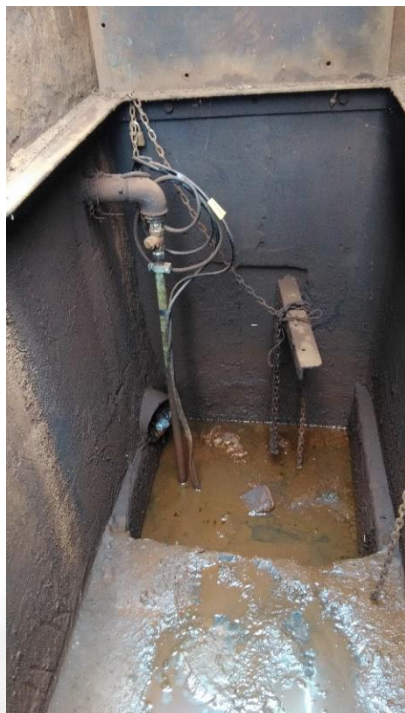
Foto 9: Bomba de sucção da vala de troca de óleo e de lubrificação.
