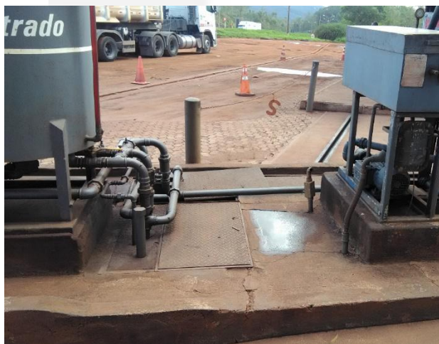
Foto 15: Presença de trincas no piso (área dos filtros prensa).
