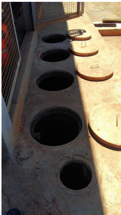
Foto 13: Sistema separador de água e óleo - SAO.
