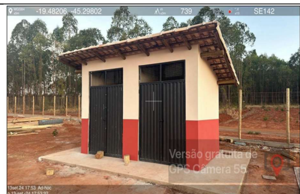
Foto 05. Depósito Temporário de Resíduos Sólidos
