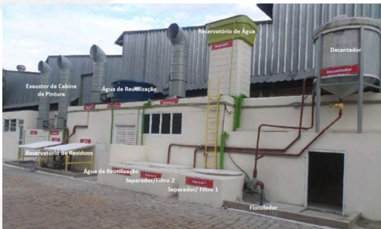
Figura 11 – Estação de Tratamento de Efluentes Industriais instalada na Unierre Móveis Ltda.
