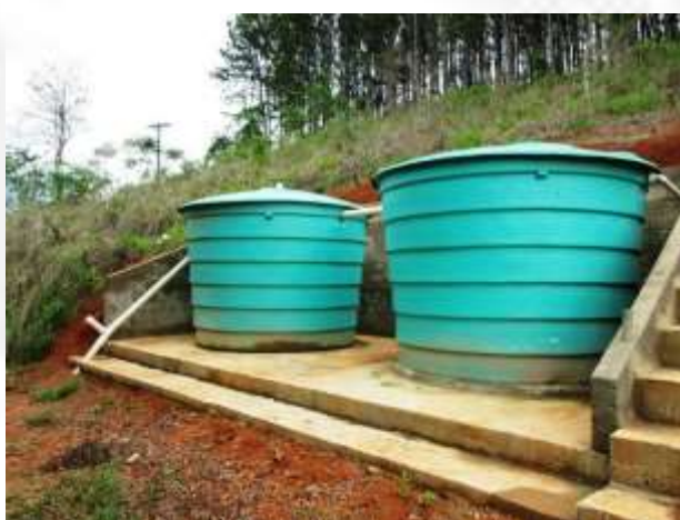
Figura 9 – Sistema de tratamento de efluentes líquidos sanitários instalado na Unierre Móveis Ltda
