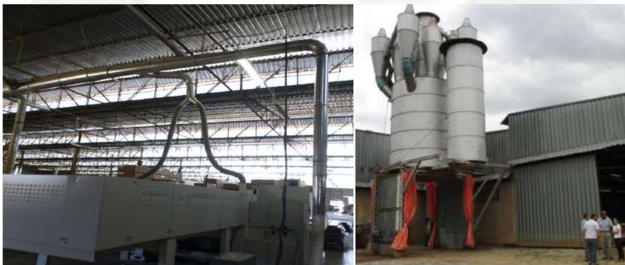
Figura 13 – Exaustores instalados no setor de corte (esquerda) e silo provido de saias para controle da emissão atmosférica (direita).
