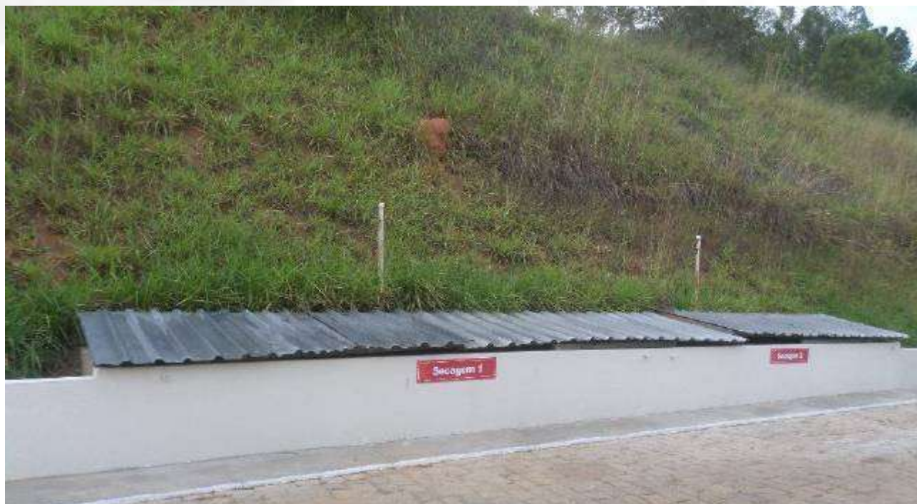
Figura 12 – Leito de secagem de resíduos industriais, tampado e com muro de contenção, instalado na Unierre Móveis Ltda.
