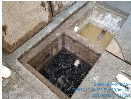
Foto 02. Visão da caixa de gordura e caixa com carvão e brita
