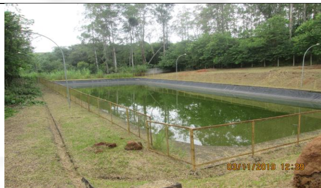
Foto 04: Lagoa do Sistema de Tratamento de Efluentes
