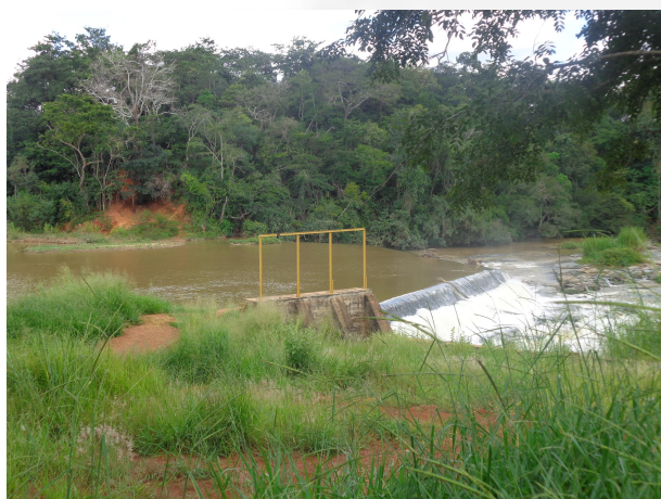
Foto 01. Vista geral do barramento e comporta de entrada do canal de adução.
