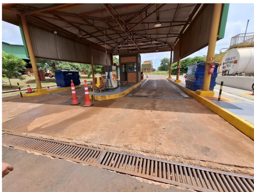
Foto vistoria: pista de abastecimento do posto
