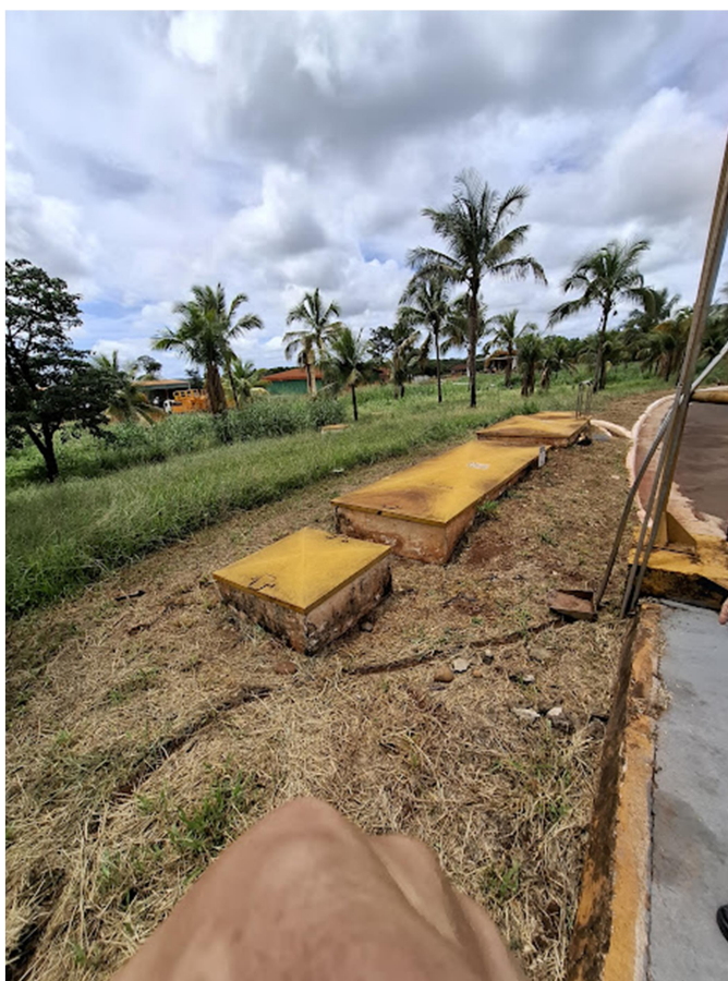
Foto vistoria: Sistema de Separação de Água e Óleo
