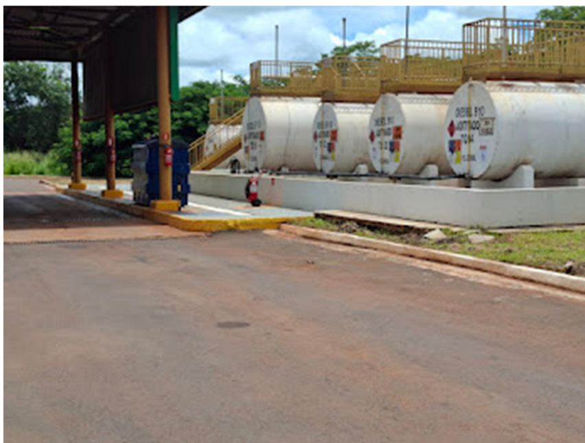
Foto Vistoria: área do atual posto
