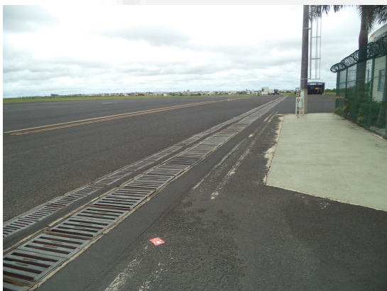
Foto 07: Canaletas para drenagem da pista direcionadas à CSAO
