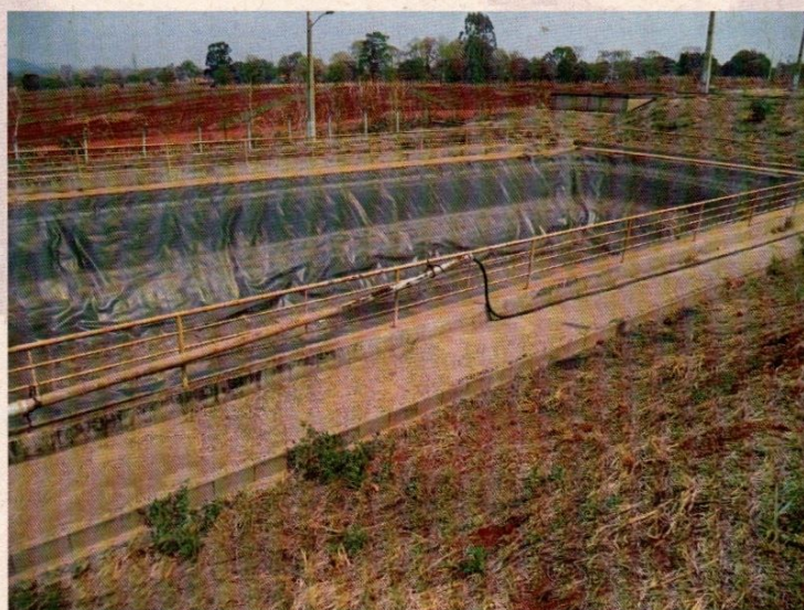
Foto da vistoria: Lagoa construída em concreto impermeabilizada com manta PAD
