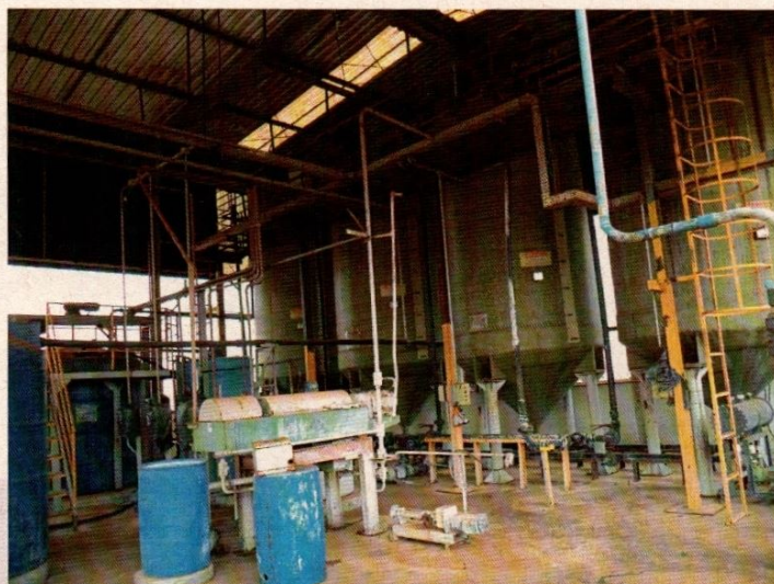
Foto da vistoria: ETE existente na área industrial
