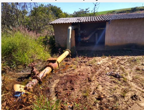
Outra casa de máquinas para captação no barramento
