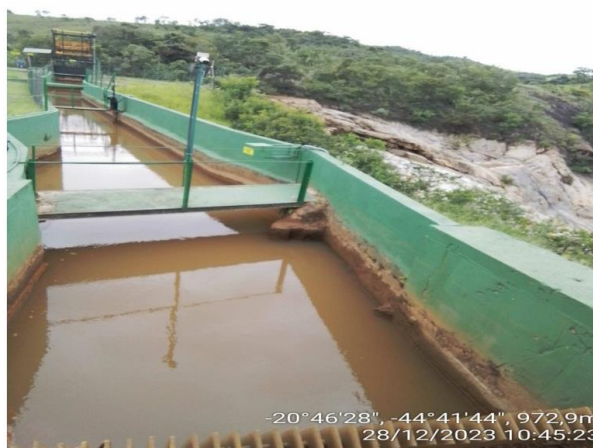
Foto 03. Canal de adução.
