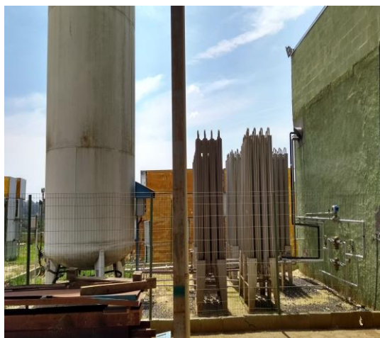
Foto 04. Armazenamento de gás nitrogênio
