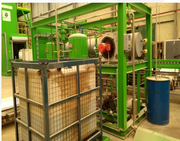
Foto 03. Remoção do óleo do compressor e do gás refrigerante
