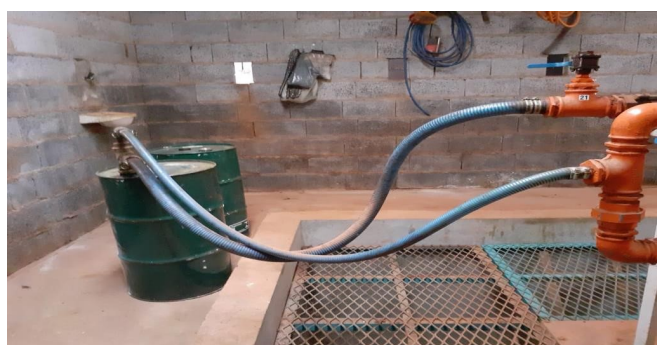
Foto 09: Sucção do produto químico para o tanque.
