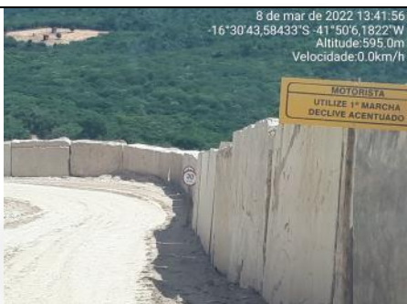
Figura 21. Blocos usados como barreira de contenção nas vias internas e placas orientativas
