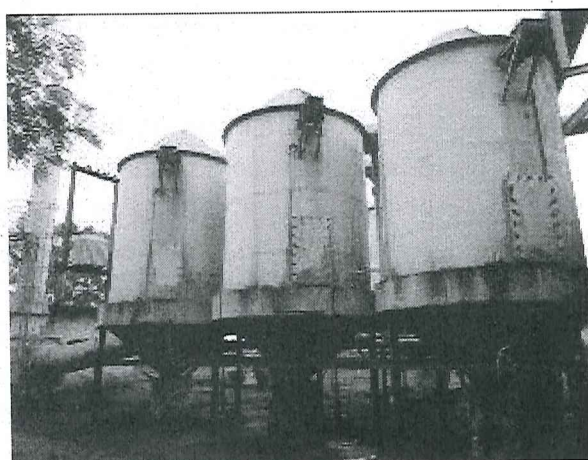
Foto 16. Filtro de mangas do peneiramento.
