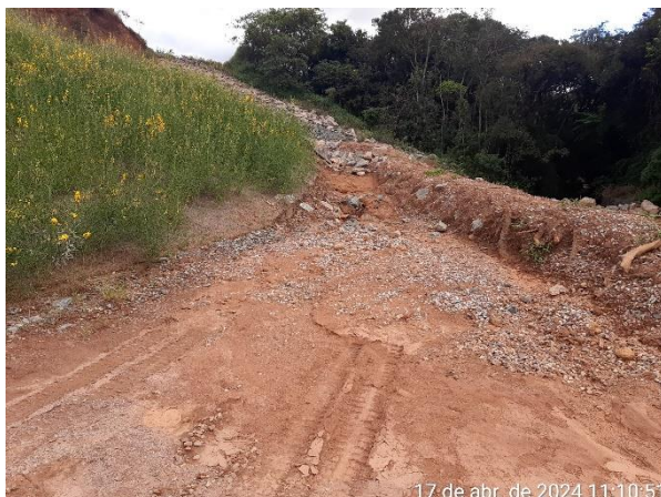
Foto 7: Evidências de carreamento de sedimentos proveniente do sistema de drenagem que não foi concluído.
