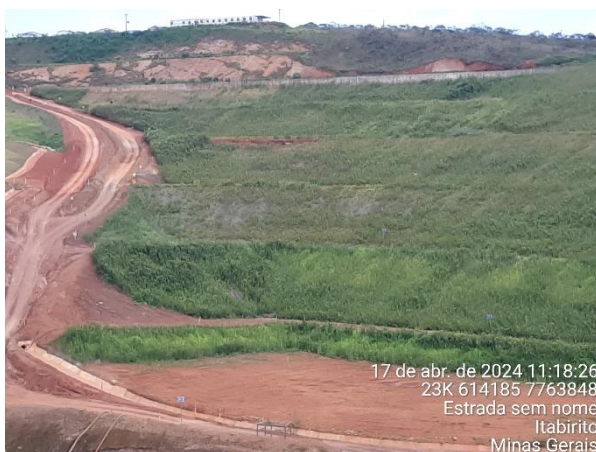
Foto 13: Berma com formação de erosão evidenciada na porção oeste do talude.
