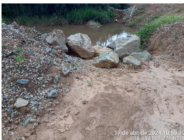
Foto 9: Ponto de direcionamento da água proveniente do sistema de drenagem com evidência de significativo quantitativo de sedimentos carreados.
