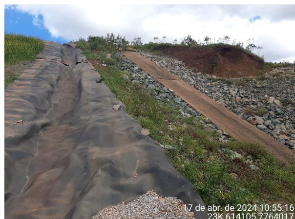
Foto 12: Detalhe da porção confinada do canal que compõe o vertedouro da Barragem de Maravilhas III.
