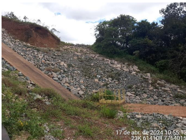
Foto 11: Porção do talude que recebeu tratamento com enrocamento de material rochoso.
