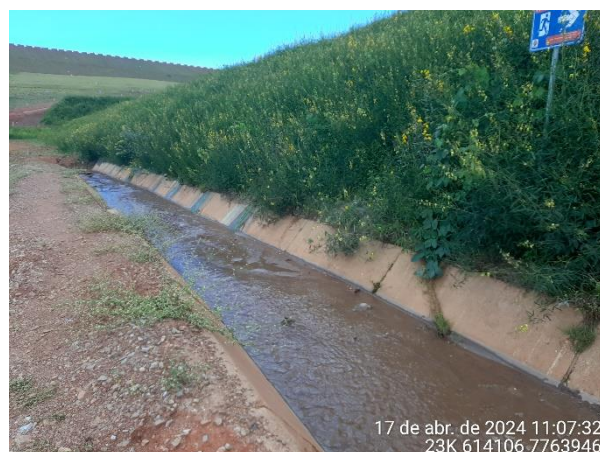
Foto 4: Sistema de Drenos Horizontais Profundos vertendo para o canal de escoamento. Cabe ressaltar que, de acordo com o empreendedor, a maior parte da água que esco no canal é proveniente do bombeamento de obra que ocorre a jusante da barragem.
