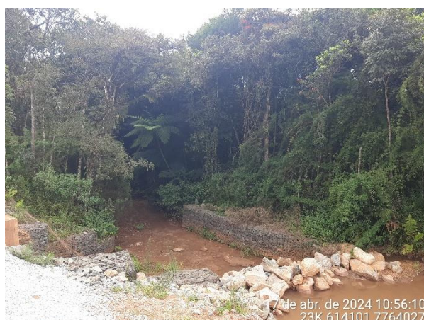
Foto 10: Estrutura de contenção de sedimentos implantada no final da drenagem.
