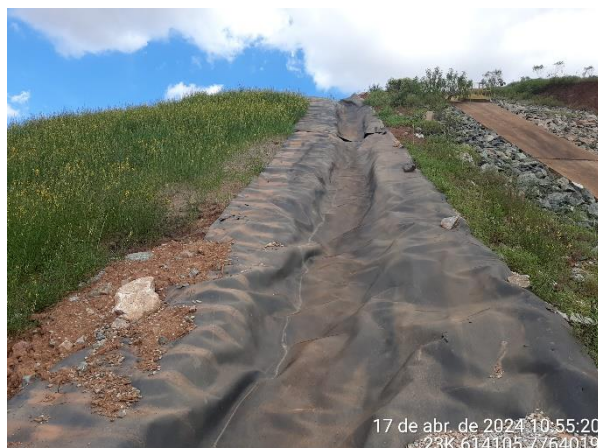
Foto 8: Parte do sistema de drenagem que recebeu manta como forma de minimizar os impactos do escoamento de água em porção do talude onde não foi concluído o sistema de drenagem.
