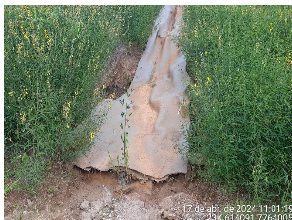
Foto 4: Sistema de Drenos Horizontais Profundos vertendo para o canal de escoamento. Cabe ressaltar que, de acordo com o empreendedor, a maior parte da água que esco no canal é proveniente do bombeamento de obra que ocorre a jusante da barragem.
